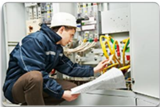
La separación del cableado de datos y el de energía debe cumplir con los códigos de seguridad.
