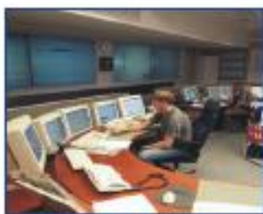
Centro de Control
