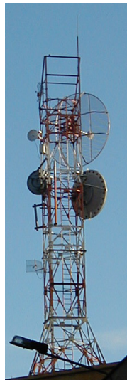
Torre Cuadrada Autoposoportada (Hasta 100 m)
