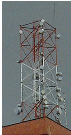
Torre Cuadrada Autoposoportada (Hasta 100 m)
