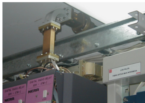
D. Detalle de conexión del radio con la guía de onda rígida con guía elíptica flexible.
