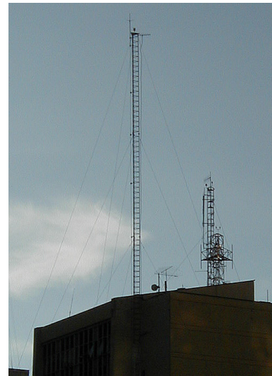
Torres ancladas (Hasta 180 m)
