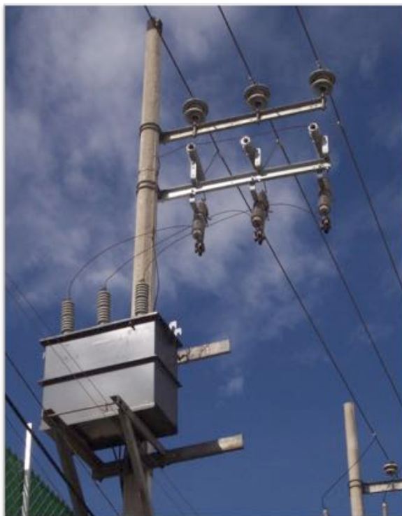
• Subestación Trifásica
