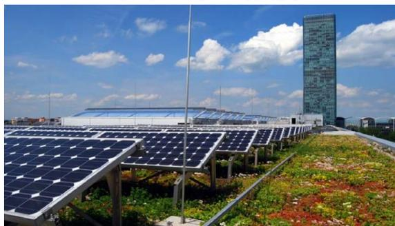
Sistema GRIPV de 75 kW instalado sobre Munich Technology Center (Alemania)
