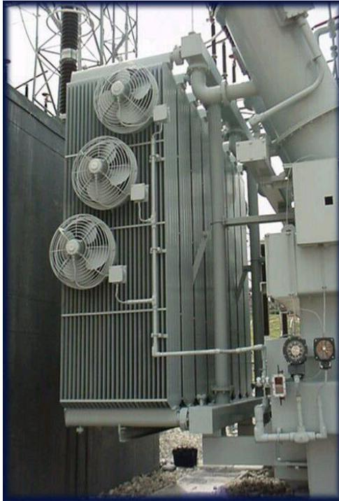
Para aquellos transformadores que por su potencia necesitan de refrigeración forzada, en caso de falla de las instalaciones auxiliares para lograr esta refrigeración, la potencia de los transformadores debe ser reducida de acuerdo a las especificaciones del fabricante.
