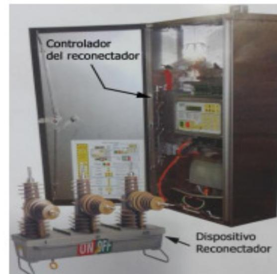
Figura 2.1.a. Dispositivos reanectadores (**Rct**) junto a sus equipos de control y/o programación.
